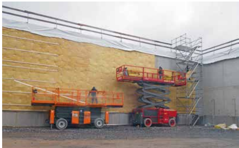
Bild oben: Fassaden-Unterkonstruktion | Unten: Fassadenverkleidung DI Dark Schick, Johannes Kaufmann & Partner
